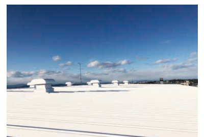
栃木県 工場 HT001ホワイト 栃木県栃木市 2020年1月竣工
